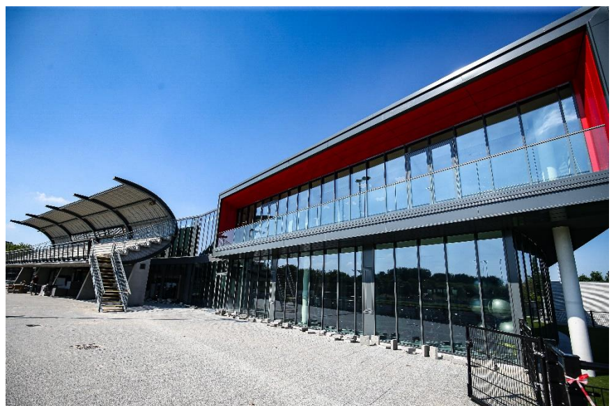
Foto Nieuw-Terbregge na renovatie
